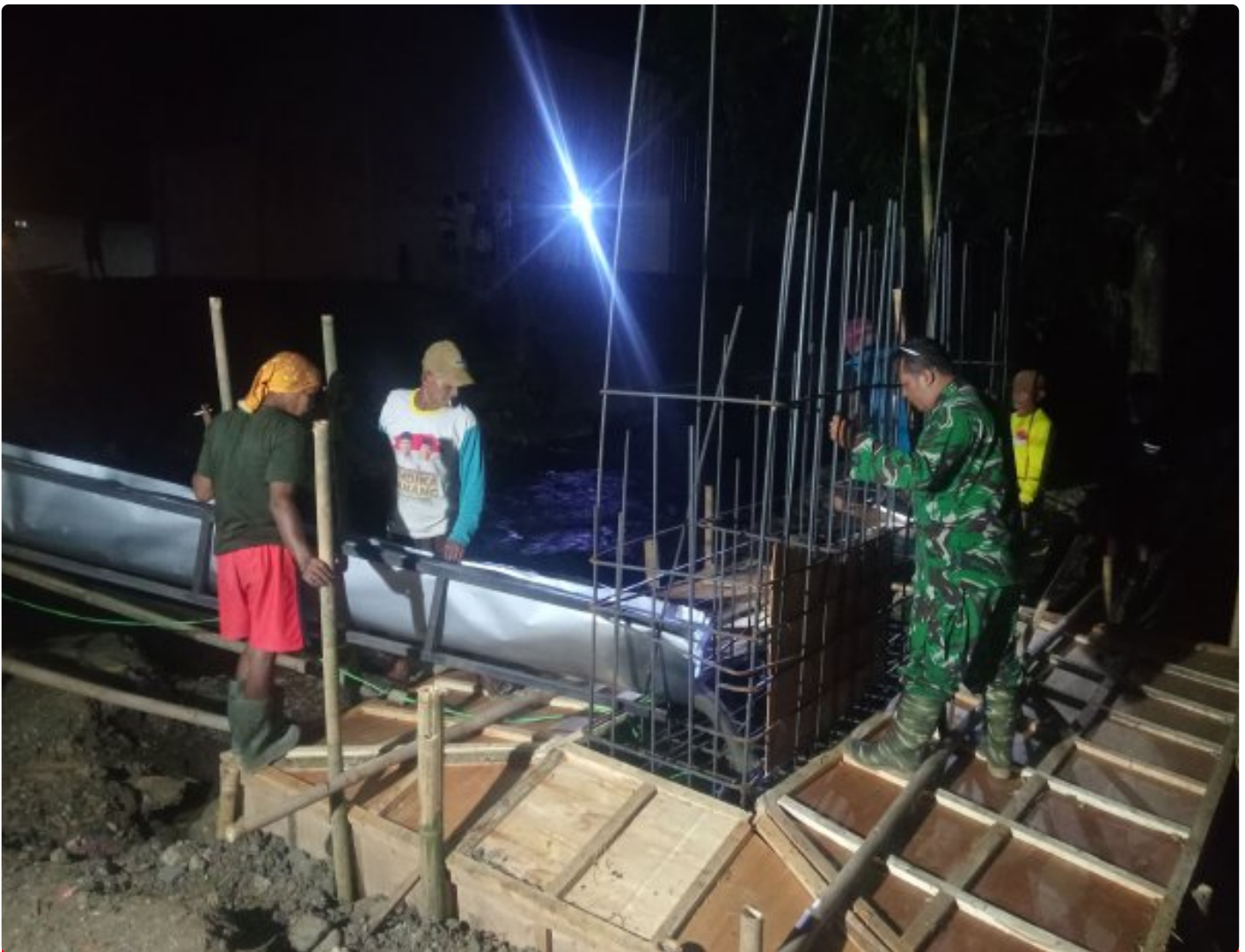
Serda Aryadi, melaksanakan pendampingan dan pemantauan kegiatan pengecoran Jembatan Garuda
