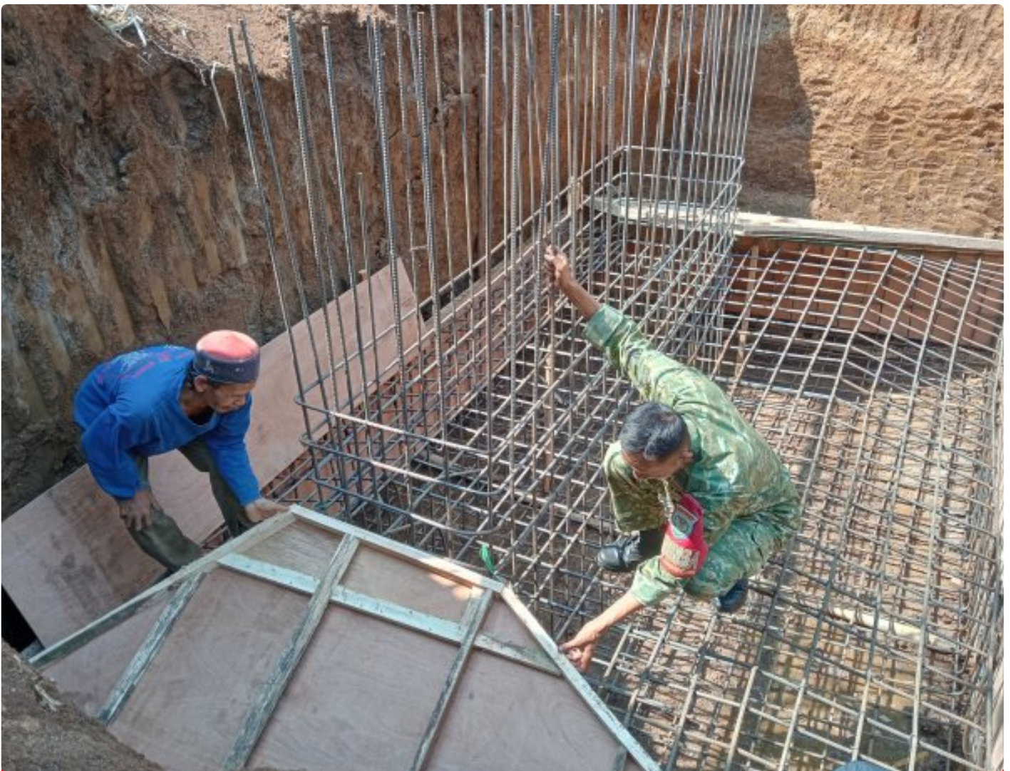
Pengecekan pemasangan bigisting
