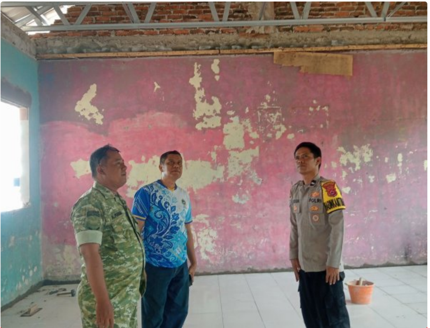
Pengawasan revitalisasi pembangunan SMP negeri 1 padarincang
